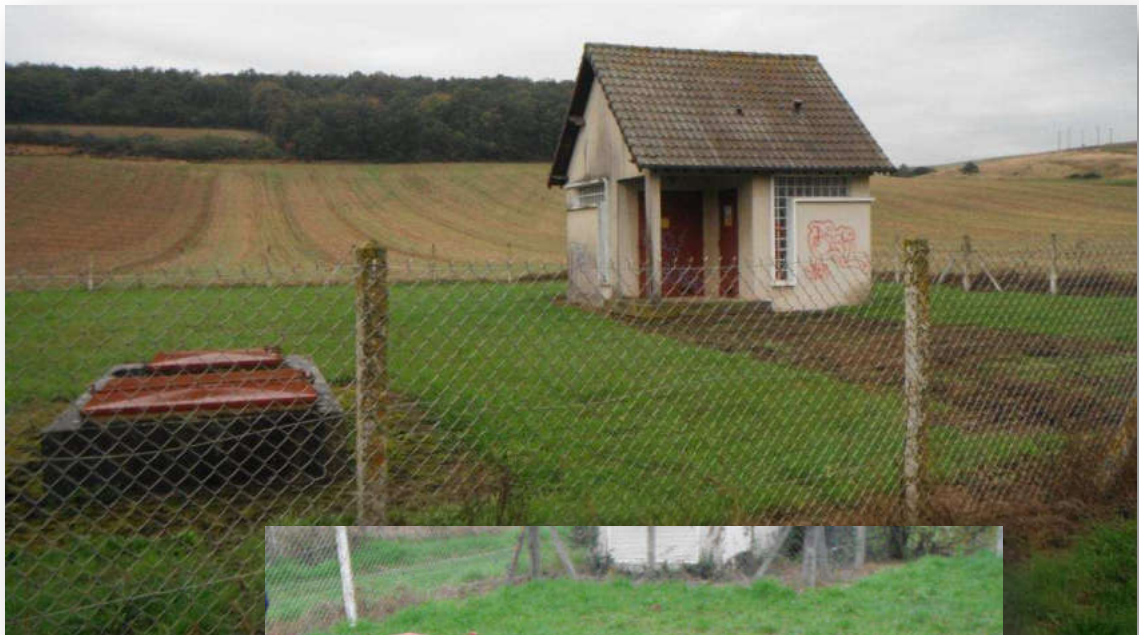
Forage du Plessis-Hébert « La Neuville des Vaux » (0150-8X-0132) – Photos du site de captage et de la tête du forage (crédit photo : explor-e)
